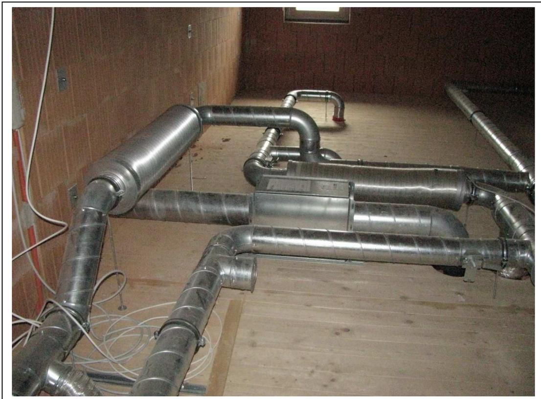
Offenes Luftzuführungssystem Dachboden (noch ungedämmt) mit Schalldämpfer
