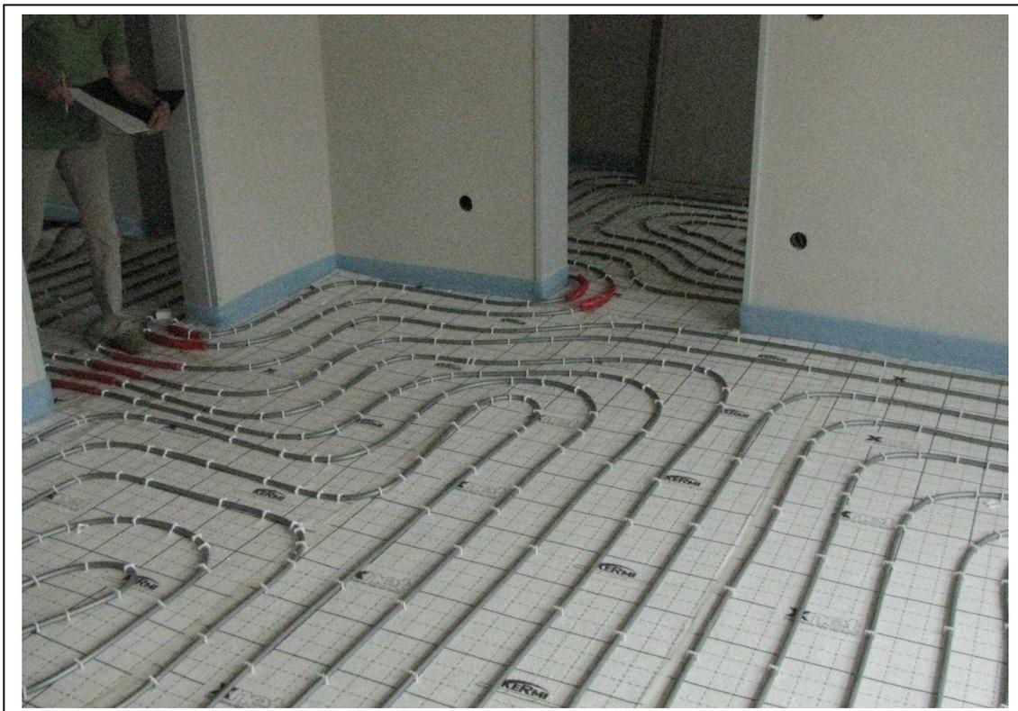
Verlegesystem der FB-Heizung, darüber kommt Heizestrich, zementbasiert
